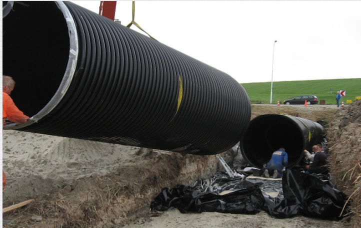
Abb. 2: PKS DN 1800 in 6-m Längen werden mittels E-Muffe zur Gesamtlänge 52 Meter verbunden.
