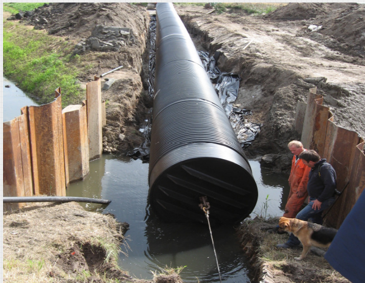
Abb. 3: Einzug der Gesamtrohrlänge mittels am Zugkopf befestigtem Seil.
