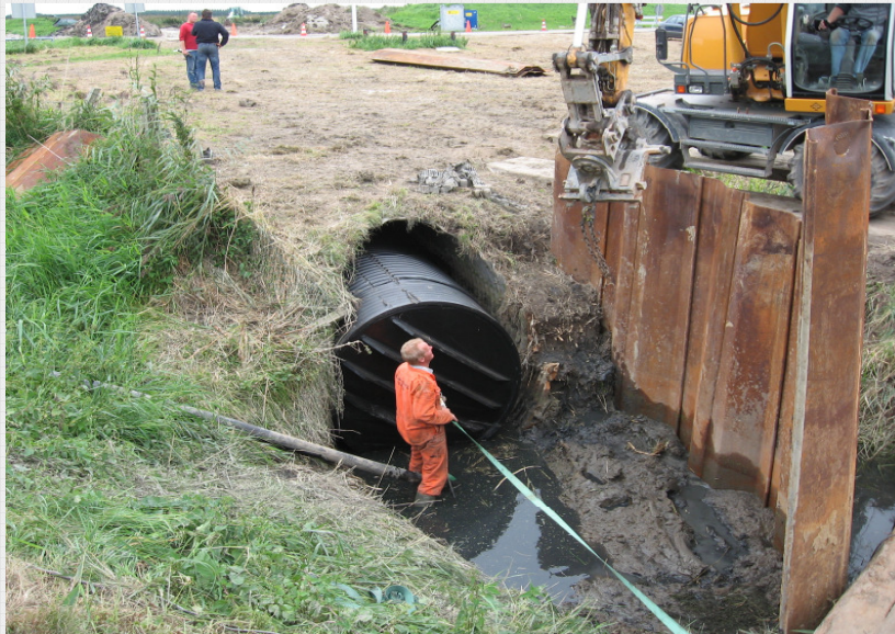
Abb. 4: Der Düker ist komplett eingezogen. Der Zwischenraum wird mit Schaumbeton verdämmt.
