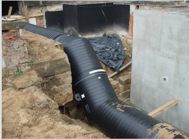
Abb. 3: Zwei Bögen DN 900 als Höhengsprung, in Sonderlängen, zur Reduzierung von Kurzlängen
