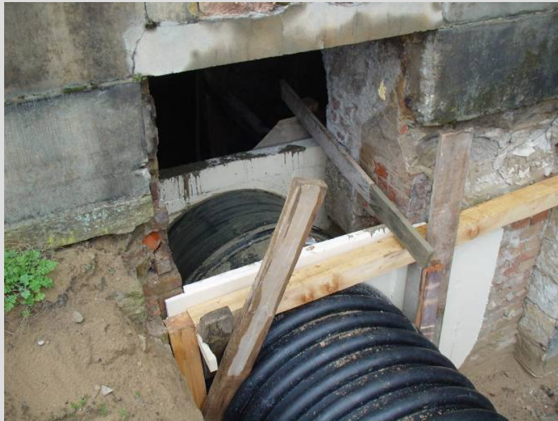
Abb. 6: Sickerwasserdichte Wandeinbindung DN 900
