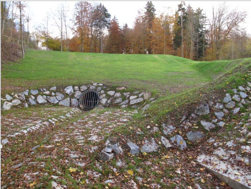
Fertig gestellter Damm im „Hansenhohl“ mit Ablaufrohr PKS DN 1400 aus PE 100
