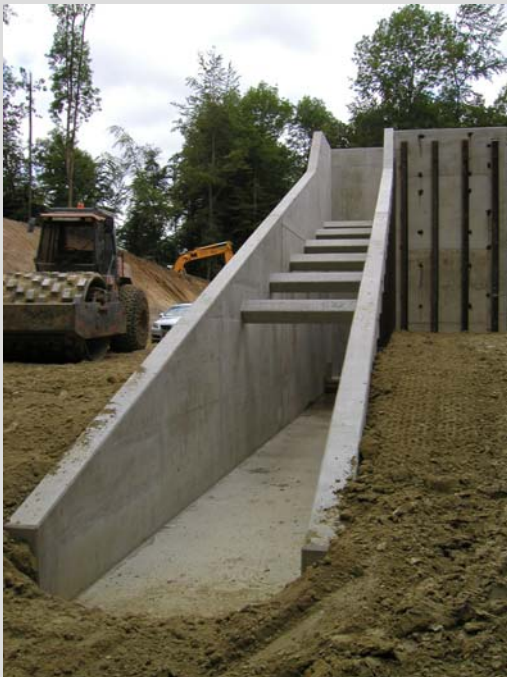
Drosselbauwerk während der Bauphase
