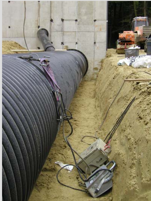
Schweißen PKS DN 1400 mit integrierter Heizwendel
