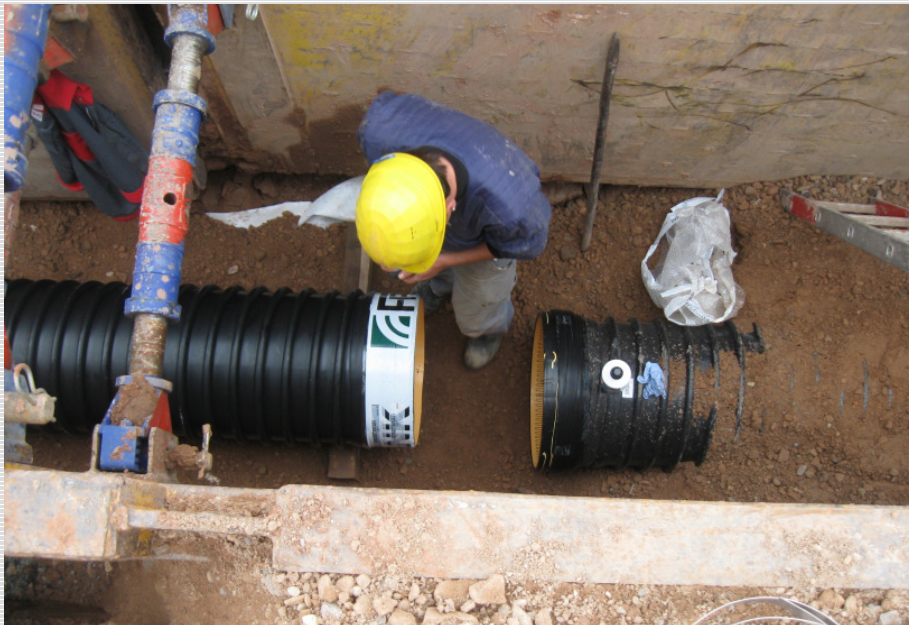
Abb. 3: PKS-Kanalrohr mit integrierter Elektroschweißmuffe
