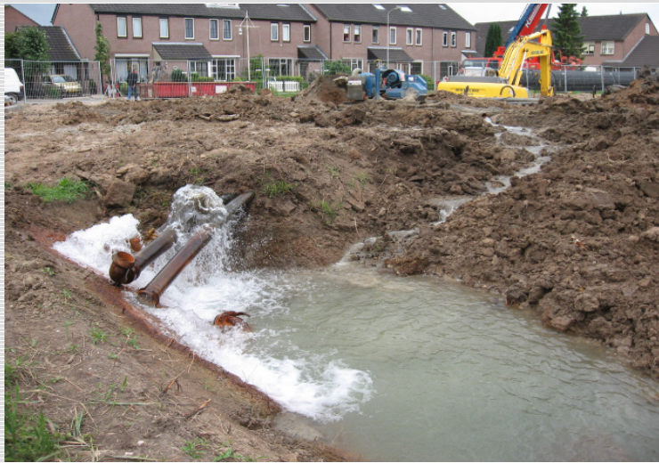
Abb. 4: Wasserhaltung während der gesamten Bauzeit notwendig
