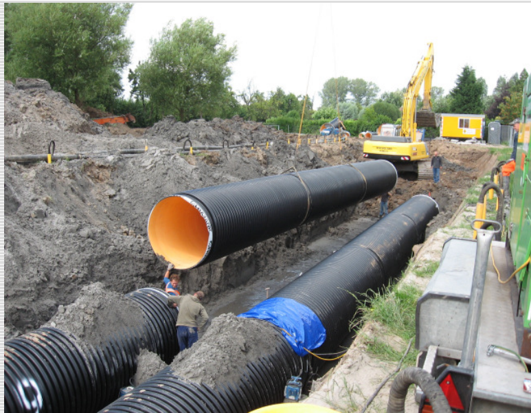
Abb. 2: Verlegung von 18 m Längen DN1600
