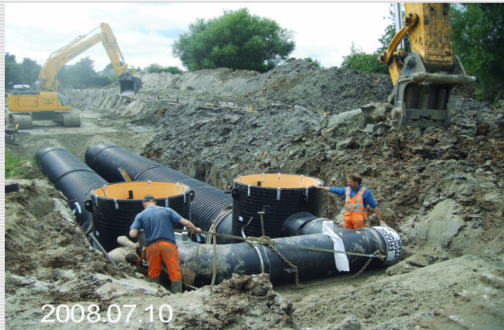
Abb. 3: Kopfschächte DN1600 mit Auslaufleitung
