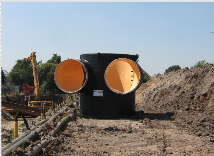
Abb. 1: Einlaufschacht DN 2700 mit Abgängen DN 16000
