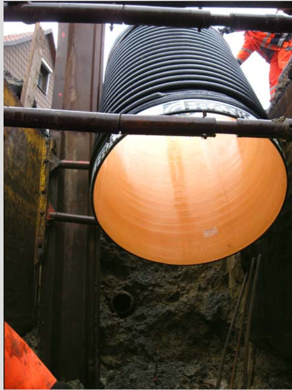
Abb. 2: Einbau der DN 1500 bei engen Bedingungen
