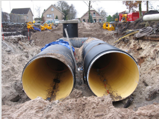
Abb. 2: Parallelleitung mit PKS-Rohr DN 2300
