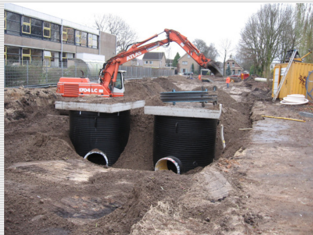
Abb. 3: PKS-Überlaufschächte DN2300
