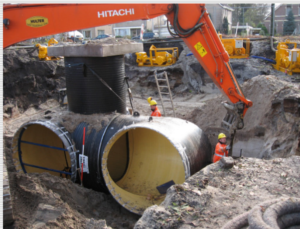
Abb: 1: Sonderbauwerk DN 2300 mit Pumpschacht DN 1800
