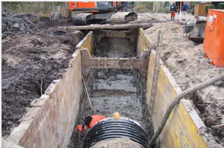
Abb. 3: Verlegung von weiteren Rohren DN1500 innerhalb der Verbaug.
