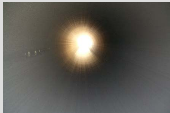
Abb. 2 und 3: Trasse mit PE-Rohr und glatter Rohrinnenfläche
