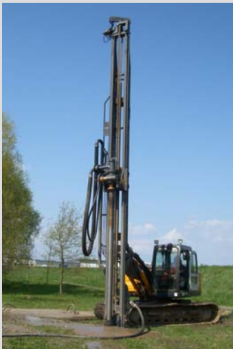
Abb. 9 und 10: Bohrgerät und Filterrohre für die Grundwasserhaltung
