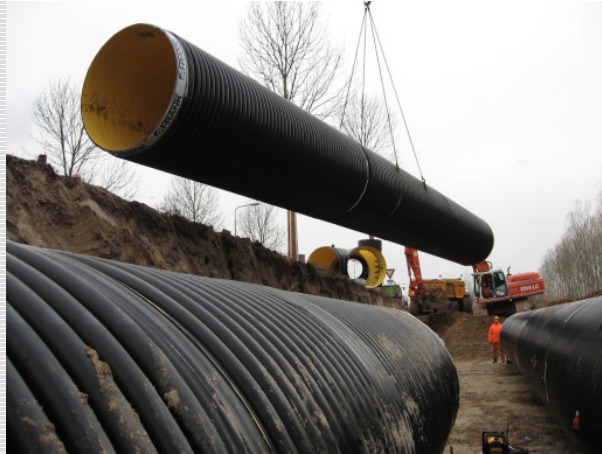
Abb. 2: Verlegen PKS-Rohr DN 1800 als 18 m-Länge
