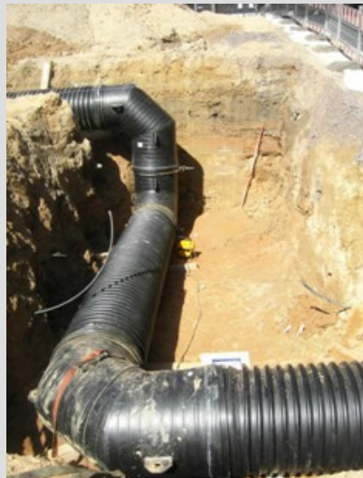
Abb. 2: Etagenbogen zum Höhenausgleich
