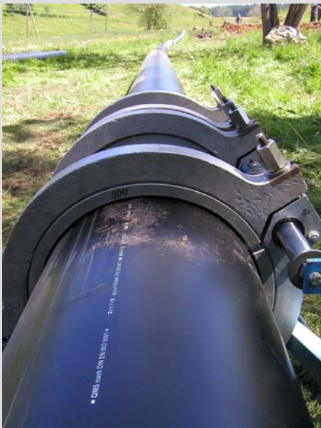
Abb. 3: Arbeitsfortschritt – Schweißen und flexibler Rohrstrang auf der Almwiese
