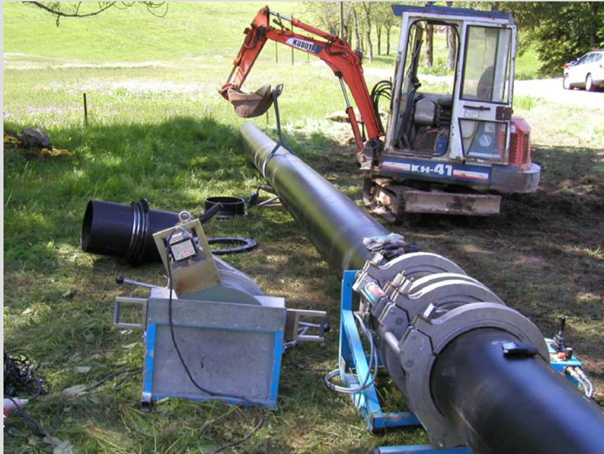
Abb. 2: Vorschweißen des Rohrstranges durch Heizelement-Stumpfschweißung
