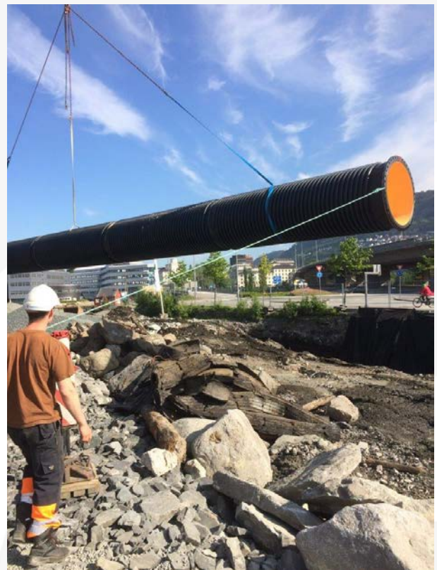
Vorkonfektionierter Strang DN 1600, Stranggewicht ca. 7,5 to.
