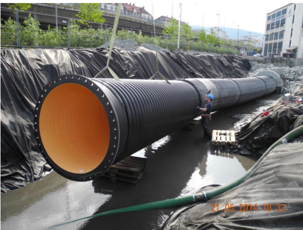
Flanschverbindung DN 1600
