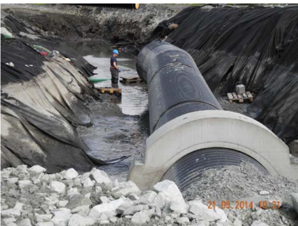
Betongewichte zur Absenkung
