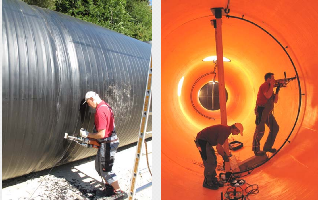
Abb. 8, 9: Schweißen außen und innen
