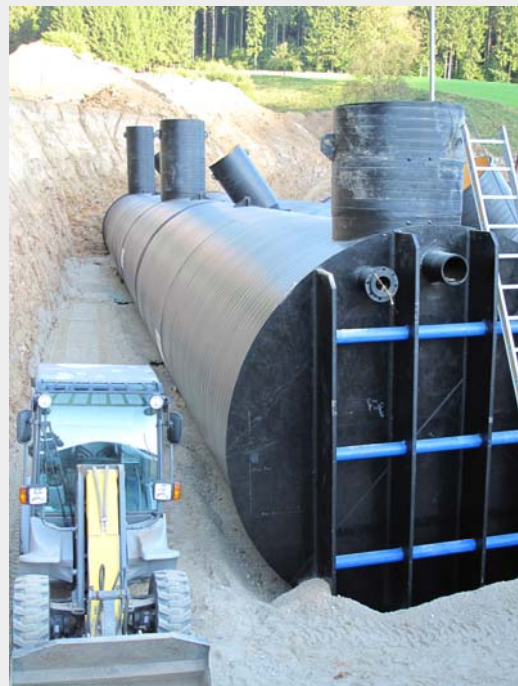
Abb. 6, 7: Ausrichten mit Mobilkran und Einbau der seitlichen Bettung mit Kleingerät
