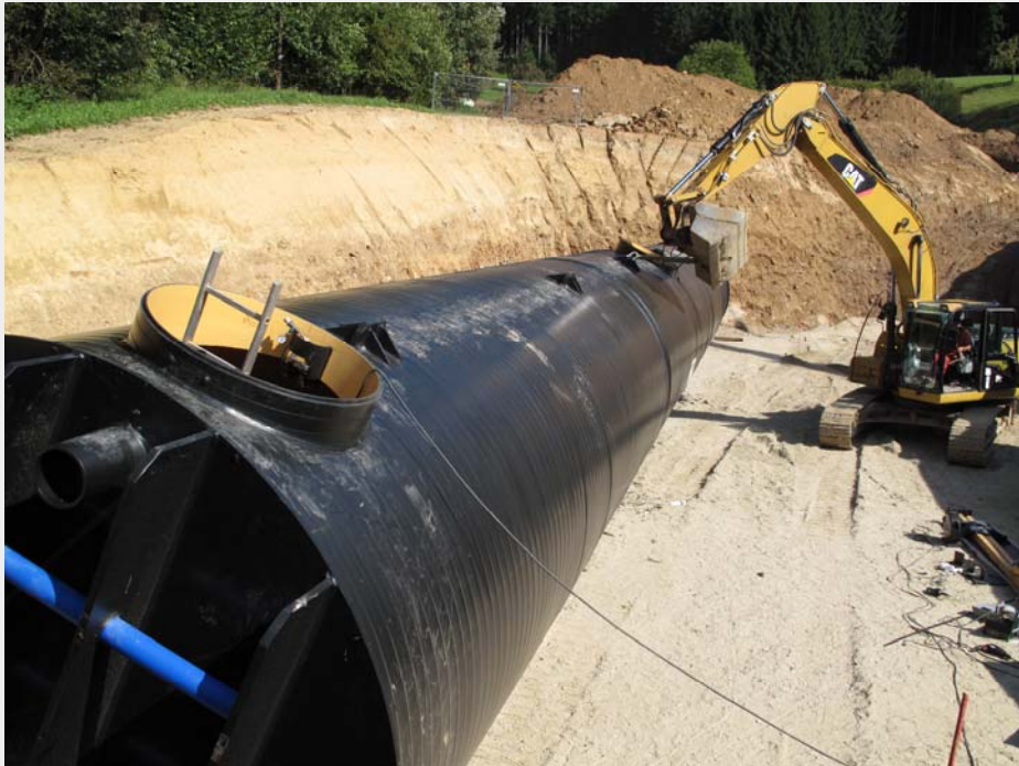
Abb. 5: „Drehen“ der Behälter mit Kettenbagger
