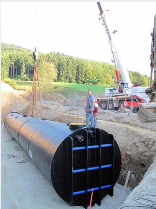
Abb. 6, 7: Ausrichten mit Mobilkran und Einbau der seitlichen Bettung mit Kleingerät
