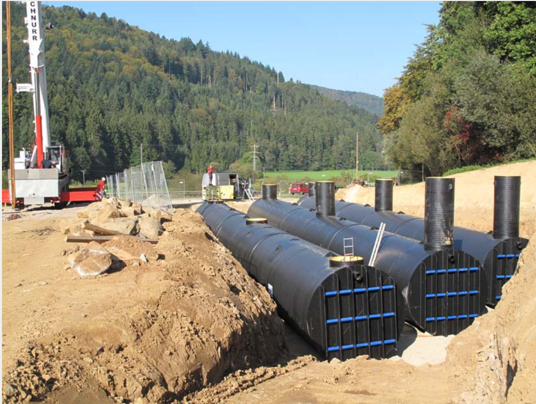
Abb. 1: Die drei neuen Sickerwasserspeicher in der Bauphase
