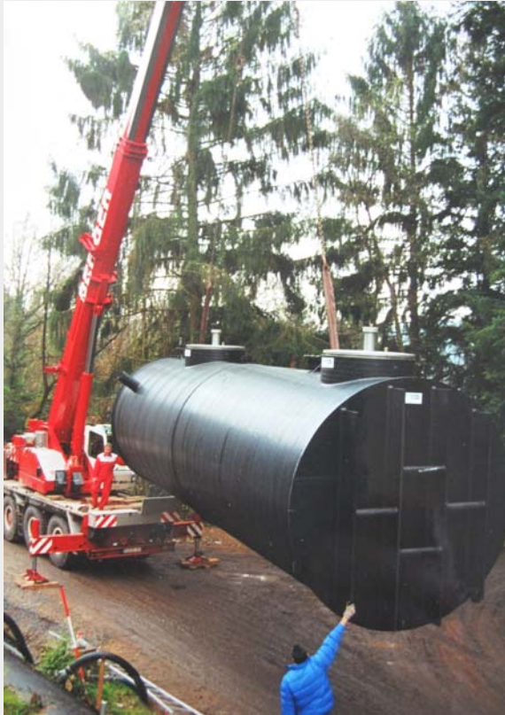
Abb. 2: Abladen und Versetzen eines Speichers aus Wickelrohr DN 3000 im Jahr 2000
