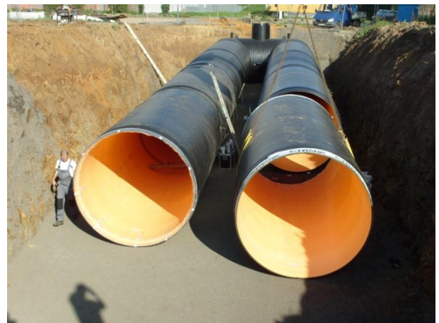
Verlegung des mehrteilig gelieferten Löschwasserbehälters
