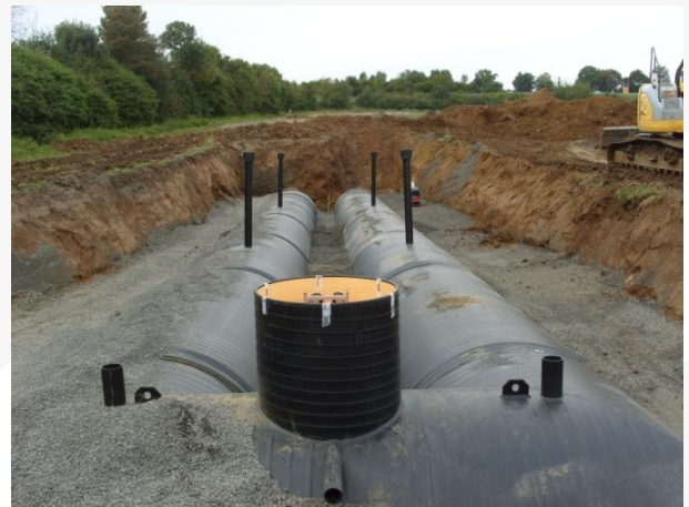
Verfüllung des Löschwasserbehälters DN 2400
