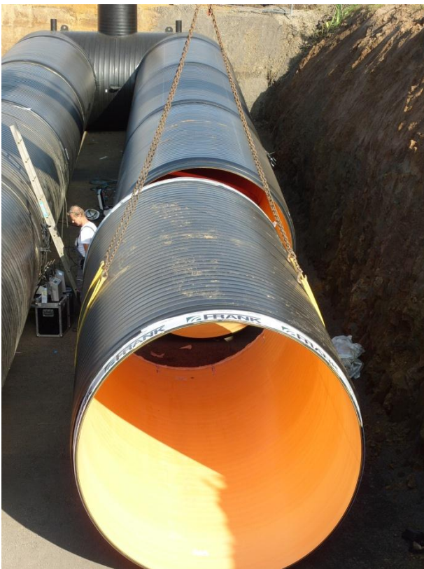
Verlegung des mehrteilig gelieferten Löschwasserbehälters
