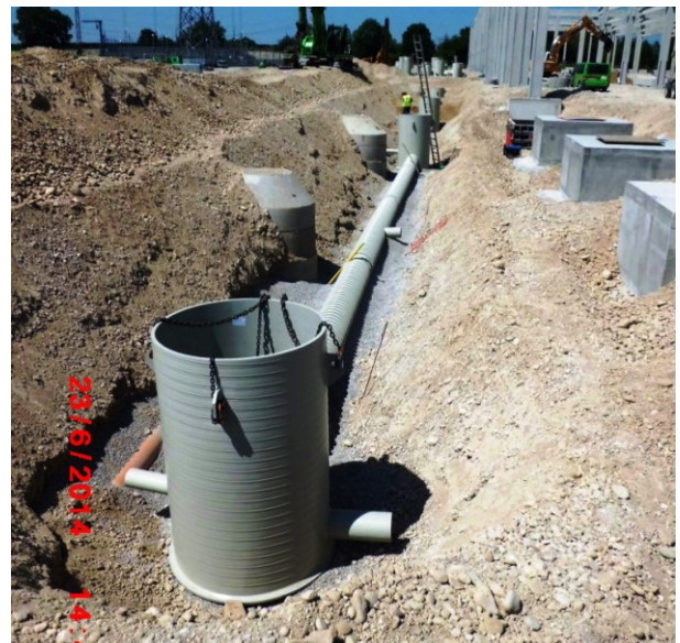
Bild 5 und 6: Systemschächte aus PP mit Anschlüssen für Druckrohr und Kanalrohr
