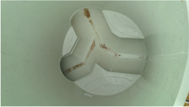
Bild 7: Systemschacht aus PP DN 1500, strömungsgünstiges Gerinne mit scheinhoher Berme
