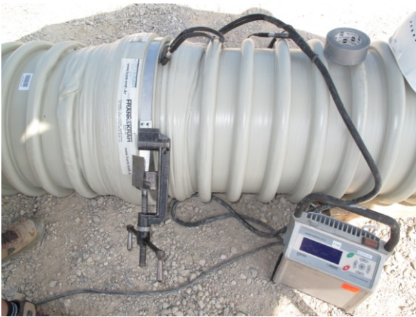
Bild 4: Schweißen der integrierten E-Muffe – Schweißgerät Polycontrol plus
