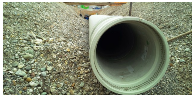
Bild 3: PKS-Rohr DN 500, integrierte E-Muffe
