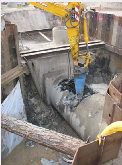
Abb. 1 und 2: Stahlbetonkanal DN 2000
