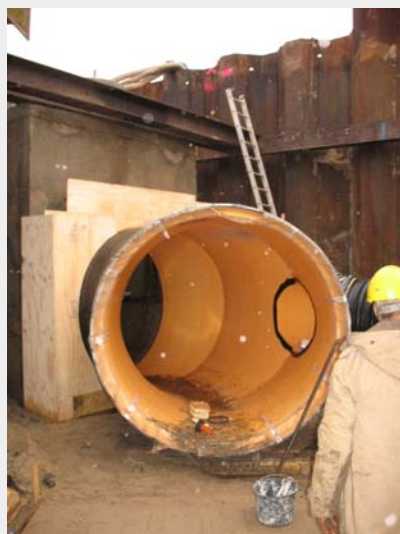
Abb. 3: Segmentbogen DN 2000 mit Festflansch und Seitenzulauf DN 800
