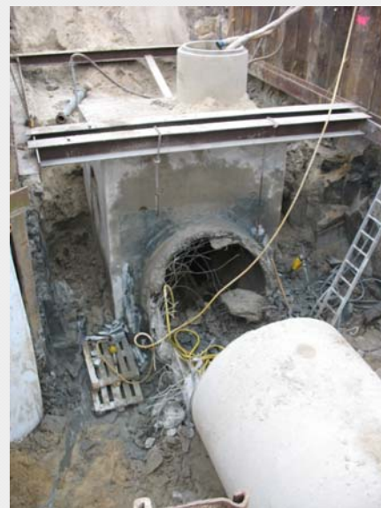
Abb. 1 und 2: Stahlbetonkanal DN 2000
