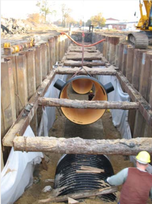
Abb. 6 und 7: Verlegung eines PKS-Kanalrohres DN 2000
