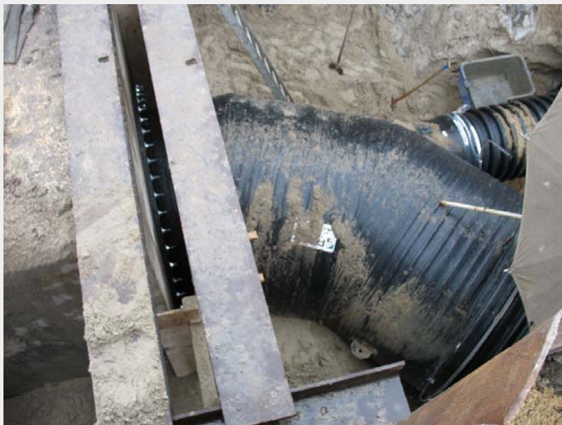
Abb. 5: Festflansch DN 2000
