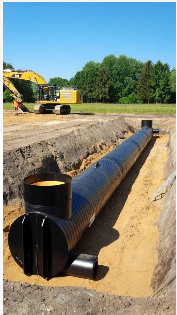
Bild 1: PKS-Secutec® Stauraumkanal DN 1200, Länge 24 Meter
