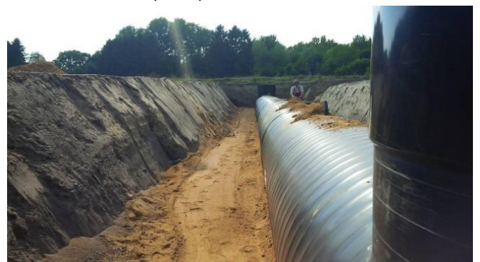
Bild 6: Lagenweise Verdichtung
