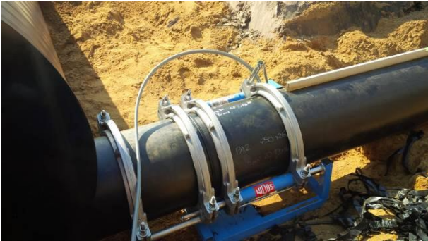
Bild 7: Simultananschweißung Doppelrohr d 450/355
