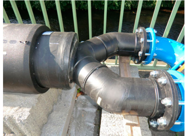
Abb. 6: PE 100 Sonderbauteil als Hosenstück d 180 SDR 11 mit Aufweitung zur Hauptleitung d 355 SDR11 und Verlängerung für Heizwendelschweißung.
