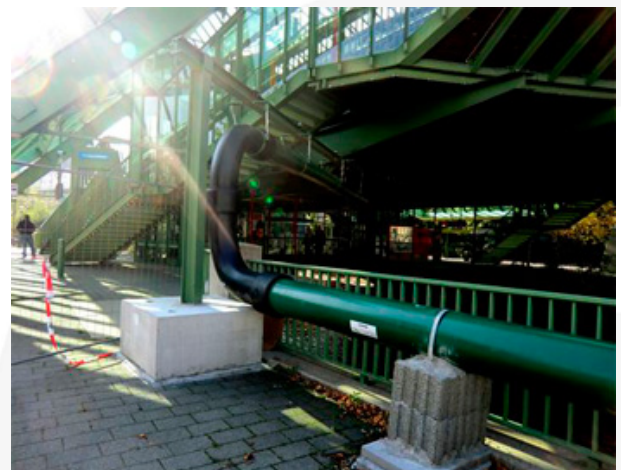
Abb. 3: Dehnungsbogen, Auflager.
