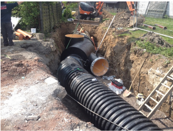
Hosenstück für Stromaufteilung (Übergang zum Bestand) mit Anschluss an Betonrohr mittels Manschettendichtung
