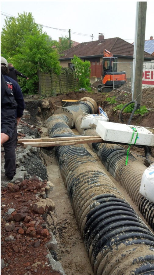
Rohrgraben mit eingebautem Flüssigboden
