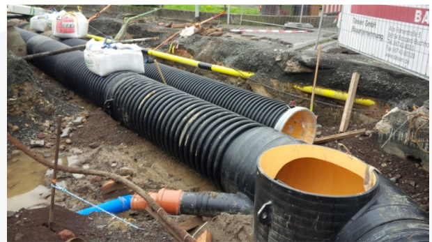
Doppelkanal DN 800 - DN 900 / Tangentialschacht DN 1000 mit seitlichem sohlgleichen Zulauf
