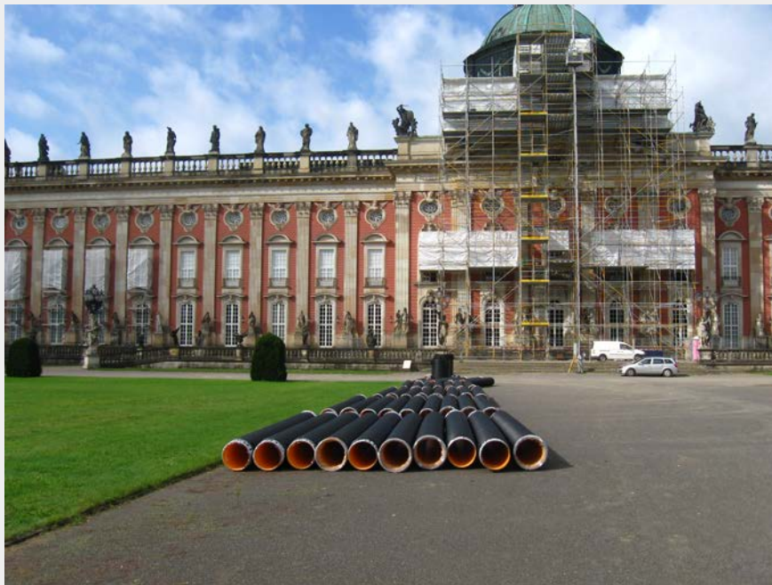
Abb. 1: Neues Palais Potsdam mit PKS Rohren DN 400
