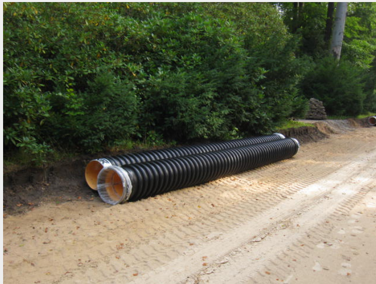
Abb. 4: PKS Rohr DN 400
