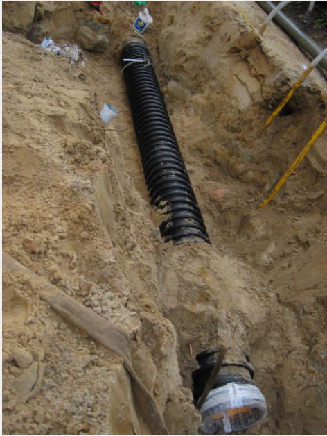
Abb. 2: PKS Rohr DN 400
