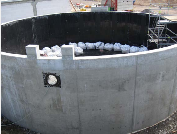
Abb. 6: Hochleistungseindicker mit Korrosionsschutzauskleidung AGRU Sure Grip Betonschutzplatte PE
