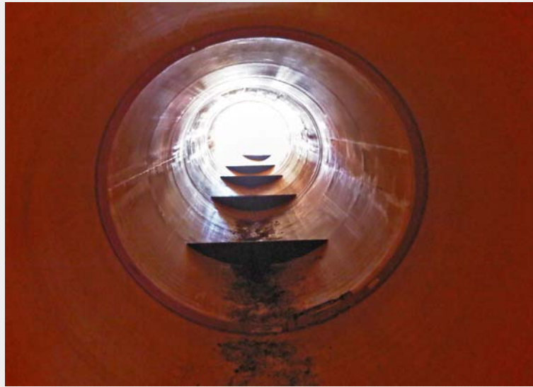
Abb. 3: PE-Stege zur Rückhaltung der Sedimente, um eine Ansiedlung der natürlich vorkommenden Pflanzen und Tiere zu ermöglichen
