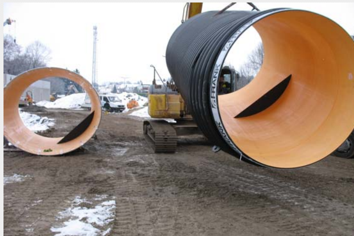
Abb. 1: Leichtes Handling durch geringes Gewicht und Einsatz von kleinem Gerät bei der Anlieferung der Rohre auf der Baustelle
