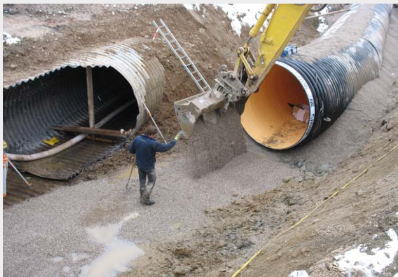
Abb. 2: Einfache und schnelle Verlegung sowie Herstellung der Schweißverbindungen unter Baustellenbedingungen
