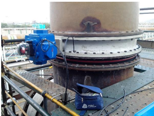
Fertiger Einbau inkl. Kompensator
