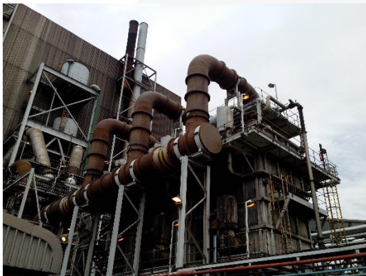
Gesamtansicht Elektrofilter 1 - 3
