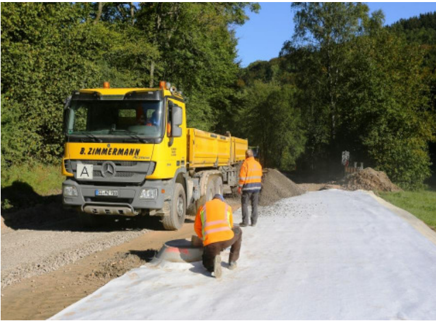
Anlieferung der Überdeckungslage
