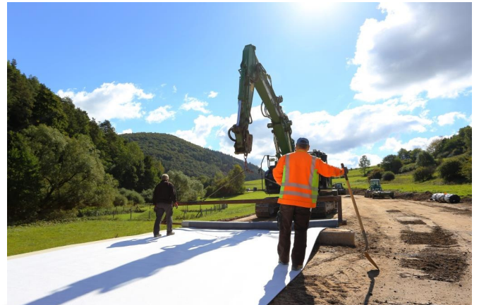
Bentonitmattenverlegung
