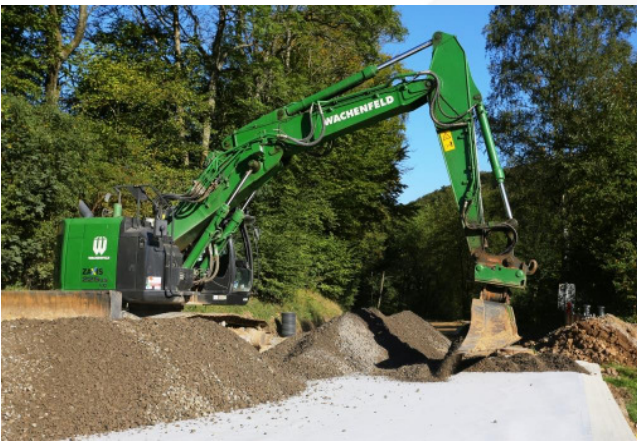
Aufbringen der Überdeckungslage
