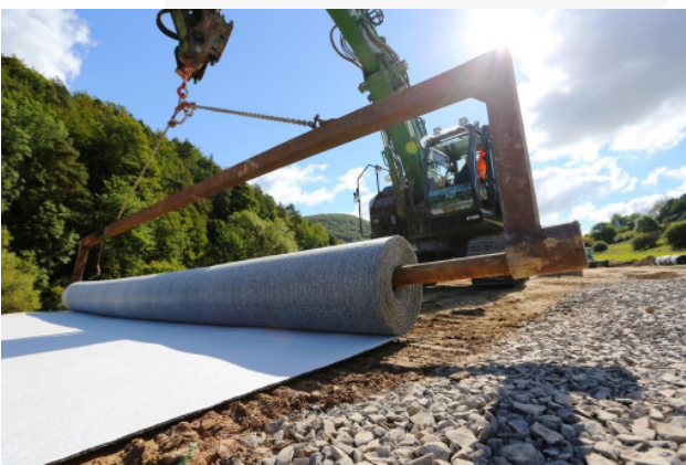
Rollen mit Verlegetraverse abrollen / verlegen
