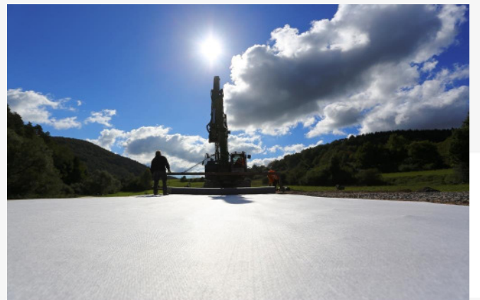
Verlegte Bentonitmatte
