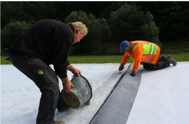
Die Überlappungen stirnseitig mit Bentonit einstreuen
