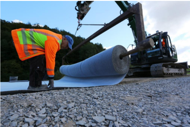
Bahnen überlappend verlegen
