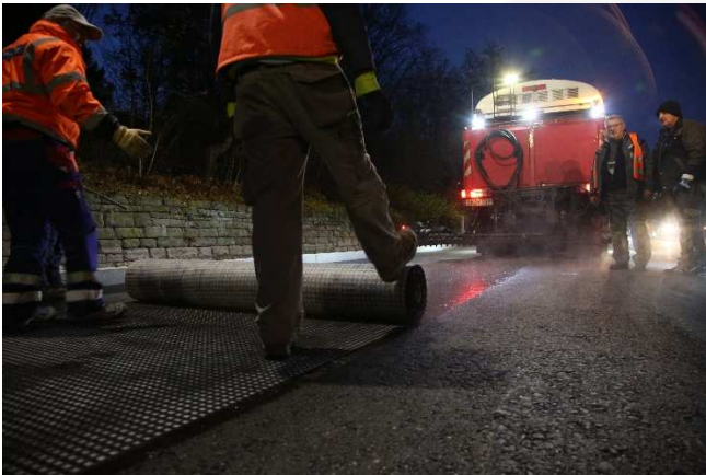
Ausrollen der Bahn
