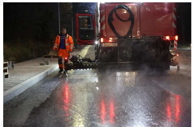
Aufbringen der Bitumen - Emulsion mit der Spritzrampe.
