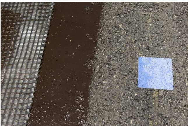
Ausrollen der Bahn
