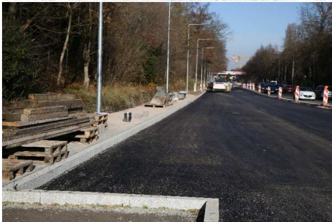
Lageplan und Baustellenansicht Stresemannstraße, Stuttgart (Kartenausschnitt aus Google Maps)
