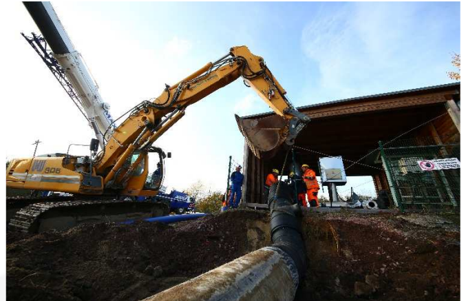
Baustellenansicht: Bau der Pumpstation Ende November 2019
