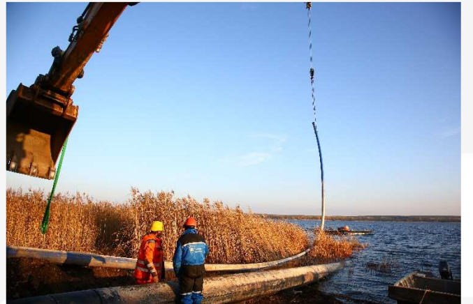
Baustellenansicht: Platzieren der Rohrleitung per Kran
