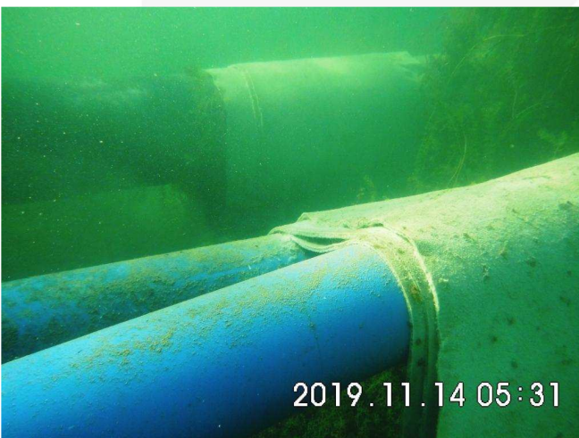
Baustellenansicht: Unterwasseraufnahme - BVR 9000 HP als Auftriebssicherung
