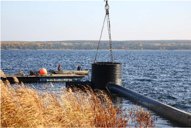
Baustellenansicht: Versenken des Schachtes im See
