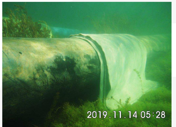
Baustellenansicht: Unterwasseraufnahme - BVR 9000 HP als Auftriebssicherung
