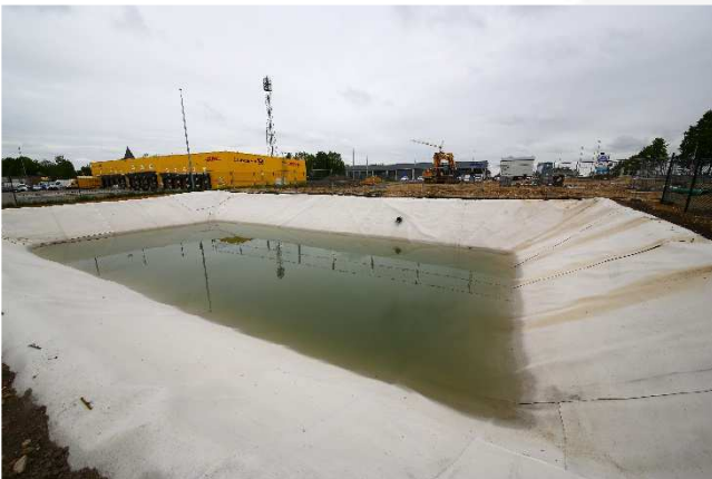
Baustellenansicht: Nach dem Wässern
