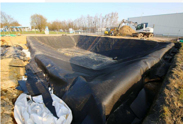
Baustellenansicht: Kunststoffdichtungsbahn komplett verlegt
