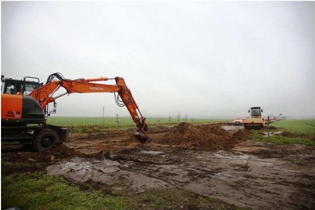
Erstellung Planum – schwierige Bodenverhältnisse!
