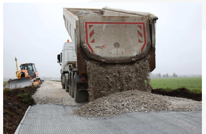
Anlieferung und Schütten von Schotter
