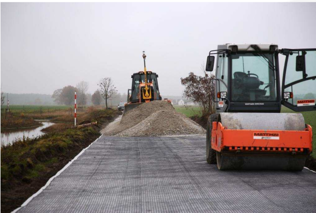
Verteilen und Verdichten des Schotters
