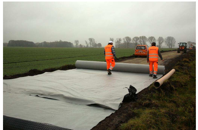
Ausrollen des Vliesstoffes JM 011/250 GRK 4
