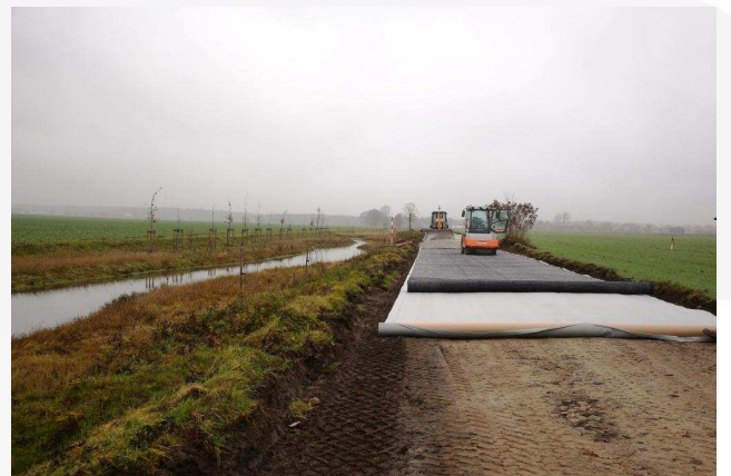
Als Besonderheit getrennte Verlegung von Vliesstoff GRK 4 (!) und Geogitter, da Kombigitter aus Geogitter + Vliesstoff nur mit GRK 3-Vliesstoff produziert werden
