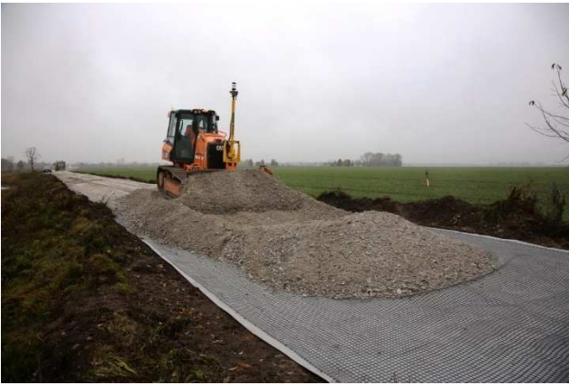
Verteilen des Schotters im Vorkopf-Verfahren
