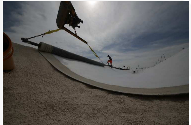
... fast fertig verlegte Bahn
