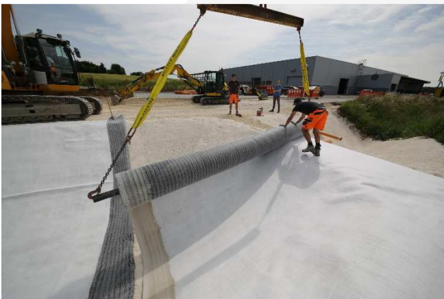
Verlegen der Tondichtungsbahn mittels Traverse
