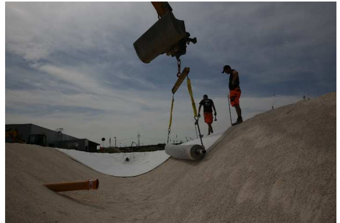
Ausrollen der Tondichtungsbahn
