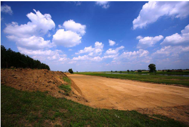
Bauabschnitt 1 Bentonitmatte eingebaut und überdeckt
