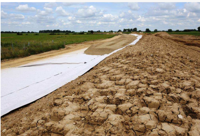
Bauabschnitt 1 Einbau des Wasserbauvlieses auf der Landseite
