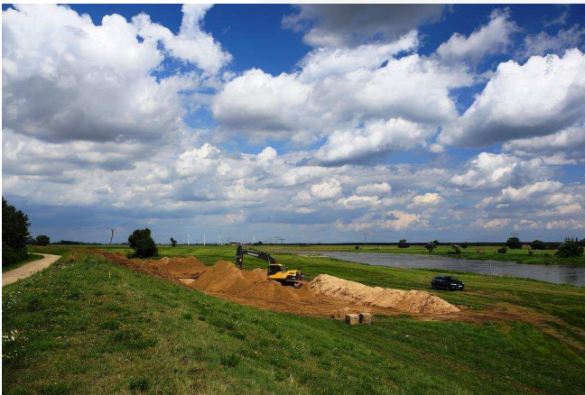
Baubeginn Bauabschnitt 1 Deichsanierung Wasserseite
