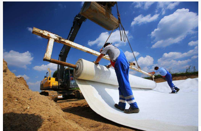
Verlegung der Bentonitmatten mit einer Verlegetraverse
