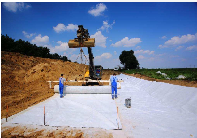
Verlegung der Bentonitmatte Bauabschnitt 1
