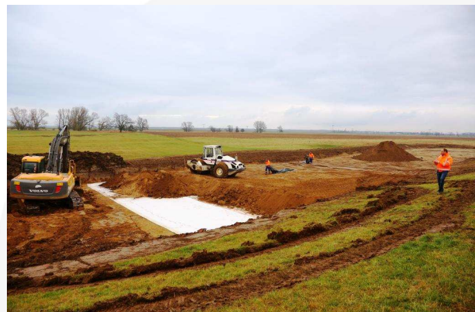
Bauabschnitt 2 Einbau Überdeckung
