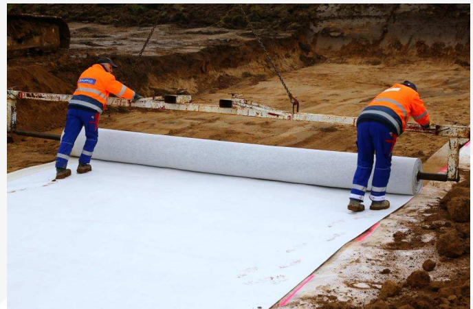
Bauabschnitt 2 Einbau der Bentonitmatte mit einer Verlegetraverse
