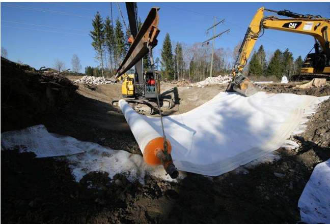
GTD-Bahnen überlappend verlegen
