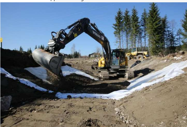
Die Überdeckung auf die Bentonitmatte aufbringen
