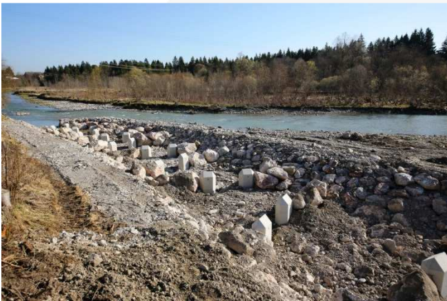
Auslauf der Fischaufstiegshilfe in den Halblech
