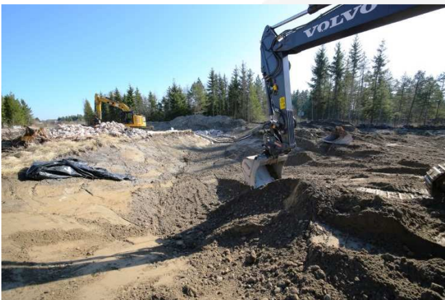
Baustellenansicht Erdarbeiten Richtung Auslauf Fischaufstiegshilfe
