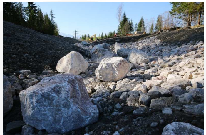
Fischaufstiegshilfe Richtung Einlauf
