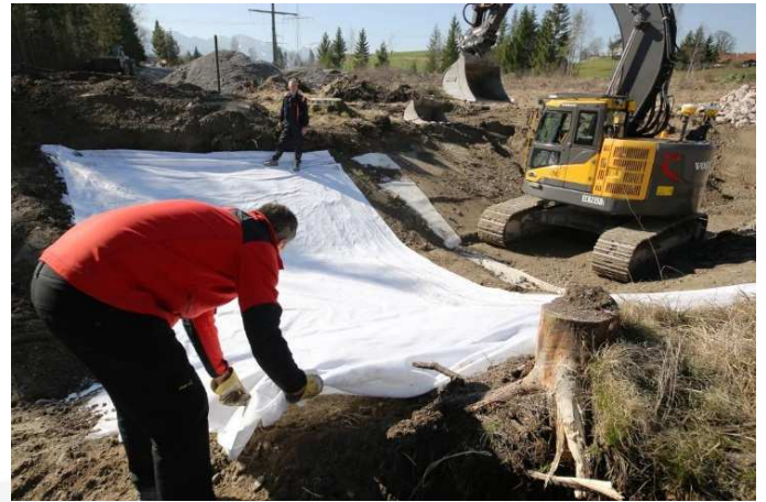
Schutzvlies als Schutz der Bentonitmatte auslegen
