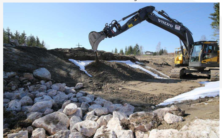
Die Überdeckung auf dem Schutzvlies aufbringen
