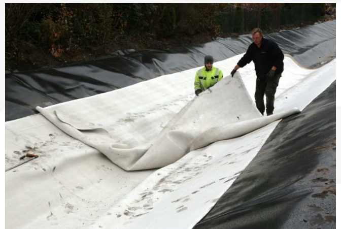
Baustellenansicht: BVR 9000 ist vor der Aktivierung flexibel zu verlegen
