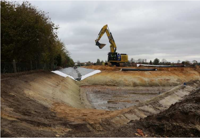
Baustellenansicht: Vorbecken mit Zulauf
