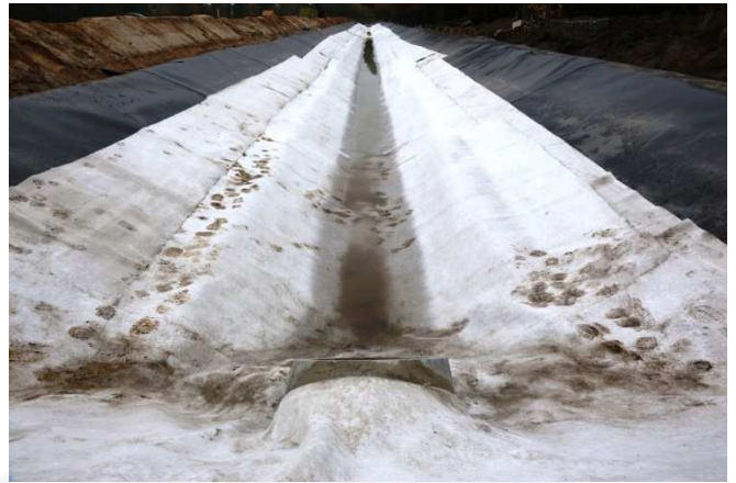
BVR 9000: doppellagige Verlegung in der Sohle
