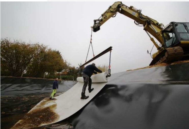
Baustellenansicht: Verlegung mit Verlegetraverse
