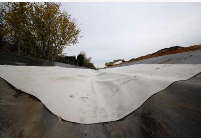
BVR 9000: textile Betonschutzlage auf der KDB
