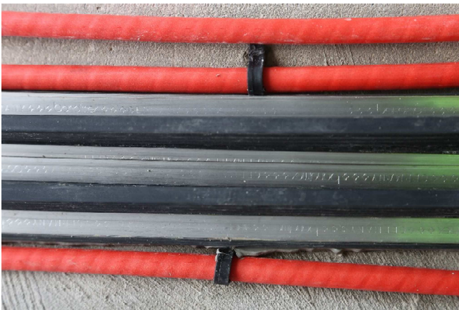
Baustellendetailansicht: Mauerkragen mit Spannbändern fixiert
