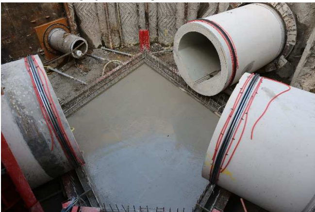
Baustellenansicht: Bodenplatte für das Schachtbauwerk gegossen
