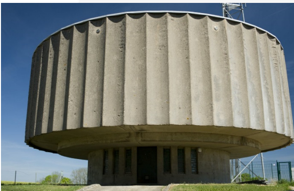
Bild 1: Alter Trinkwasserbehälter in Dippach
