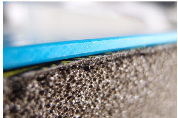
Bild 4: Auskleidung und Dämmung im Verbund
