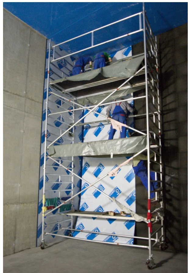
Bild 5: Wandeinbau mit untenliegender Glasschaum-Dämmung
