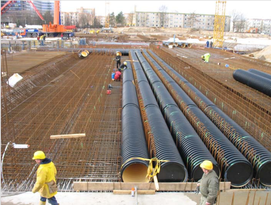
Abb. 5: Auslegen und Montieren der ersten Rohre
