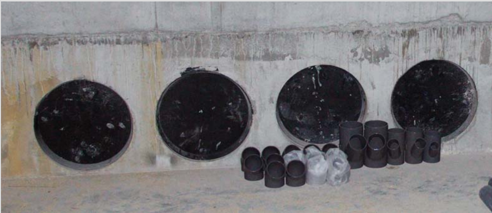
Abb. 8: Baufortschritt – Rohrenden in Bodenplatte mit Enddeckel
