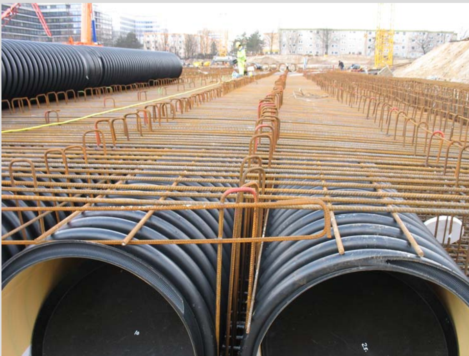
Abb. 6: Baufortschritt – Rohre zwischen oberer und unterer Bewehrung
