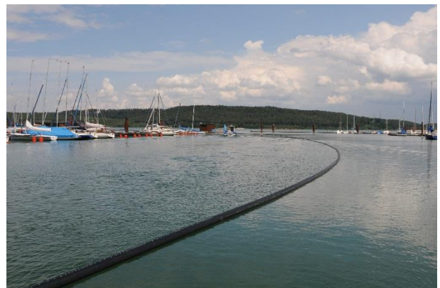
Die Abwasserdruckleitung aus PE 100-RC
