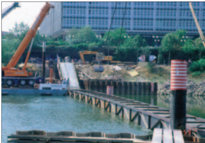
Bild 5: Einschwimmen nach kurzer Montagezeit – Neckardüker beim Absenken
