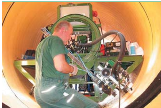
Bild 5: Extrusionsschweißung mit Roboter
