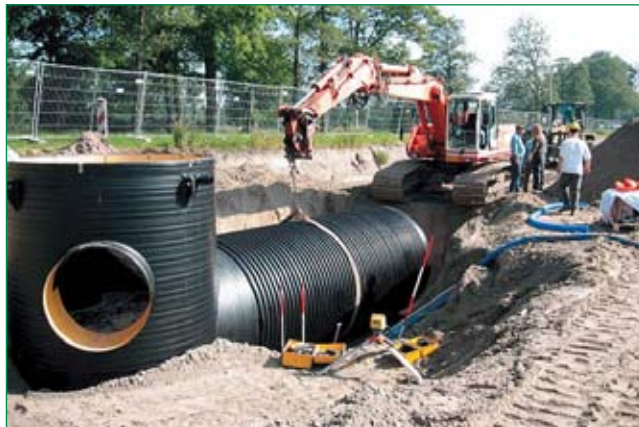
Bild 2: Verlegen der PKS-Rohre DN 2300 mm
