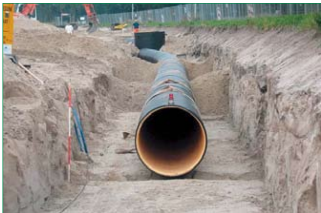
Bild 4: Verlegen der Füllleitung DN 1200 mm
