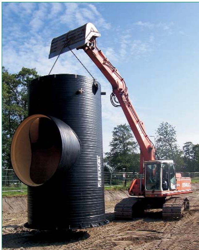
Bild 1: Setzen des Überlaufschachtes DN 2700 mm
