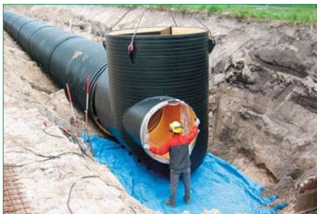
Bild 3: Setzen Übergangsschacht DN 2300 mm
