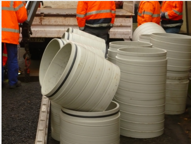
Bild 3: Kurzrohrmodule mit Dichtung
