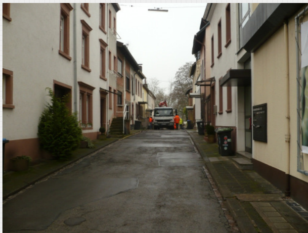
Bild 2: Zufahrtstrasse zum Einbauschacht
