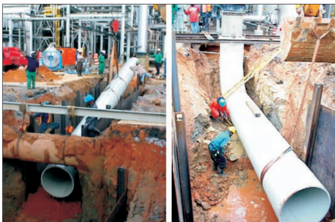
Bild 7: Installation der erdverlegten Polypropylen-Rohrleitung d 1050 mm
