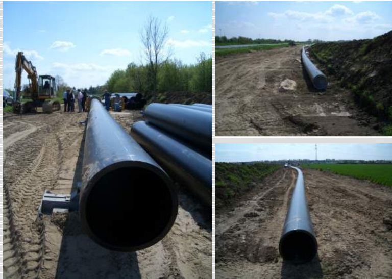
Abb. 1: PE 100 Rohr schwarz SDR 17 entlang der B 44
