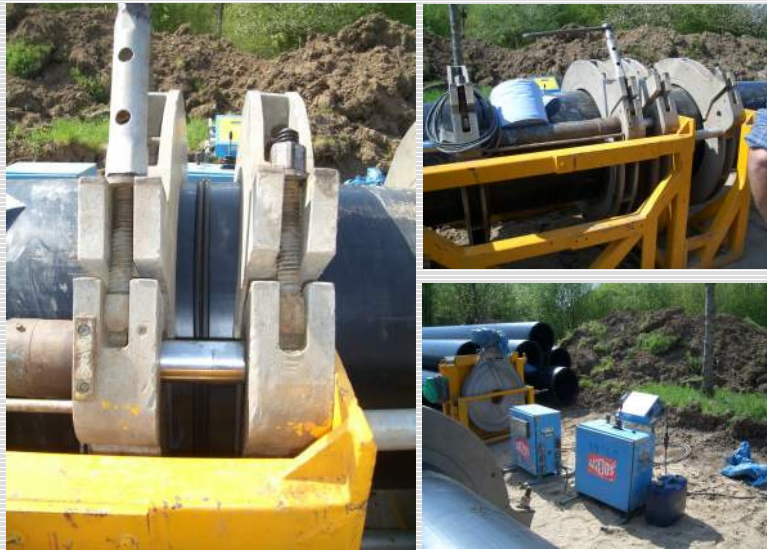
Abb. 3: Verschweißen der Rohre (Heizelementstumpfschweißung)
