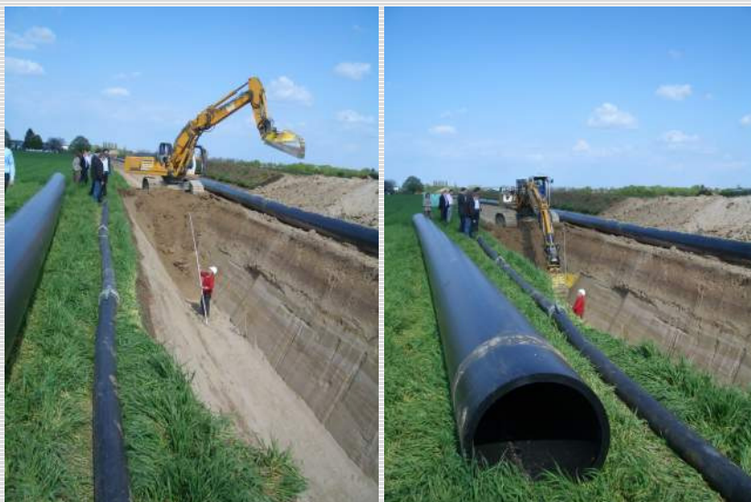
Abb. 2: Grabenerstellung und Verlegung des Rohrstrangs
